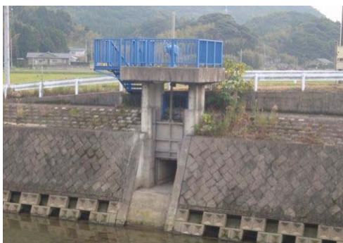
写真 4.1.1-1 引上げ式ゲート樋門
