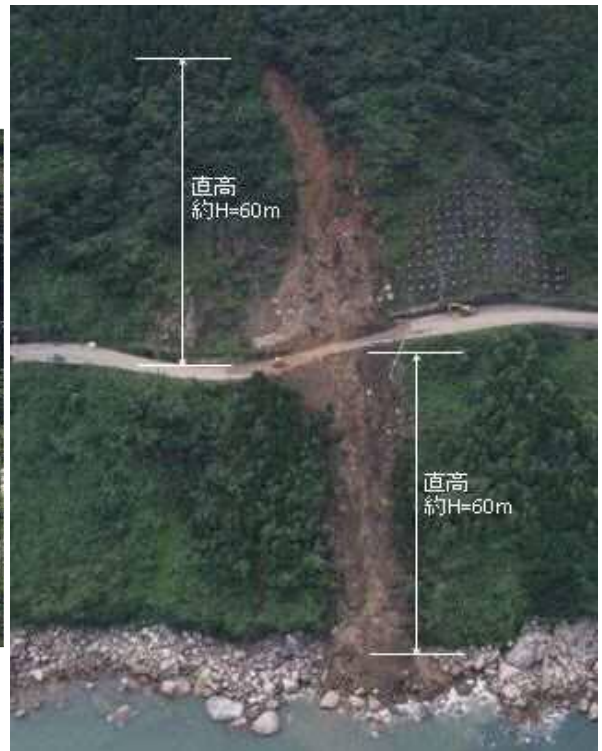
6/23～6/28の梅雨前線豪雨 鹿児島県肝付町水尻 一般国道 448号
