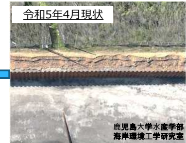
応急対策で消波ブロックを設置
