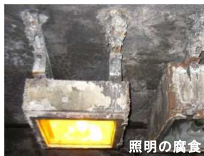
図 1-10 トンネル内附属物の損傷事例
