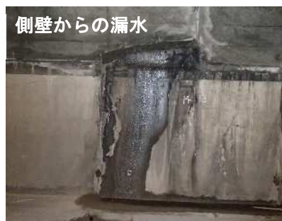
図 1-8 トンネル本体工の損傷事例
