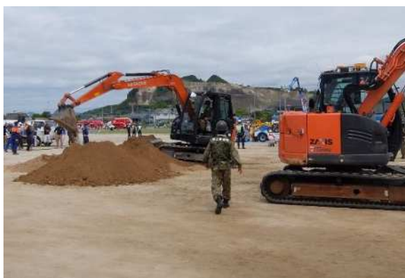
県建設業協会と陸上自衛隊が 連携した土砂・倒木撤去
