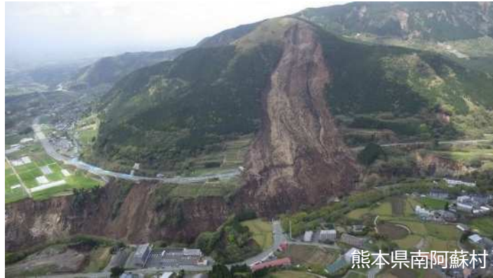
図 2-5 道路の被災リスク（法面崩壊） 7)
