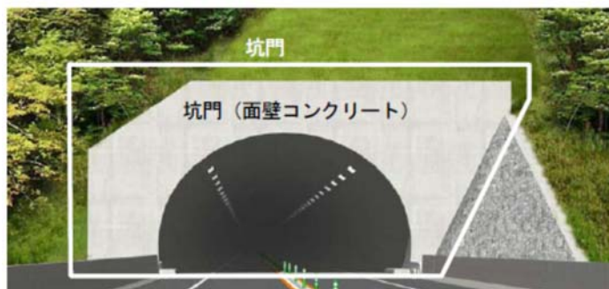
図 5-2 点検対象箇所（トンネル坑口部）
