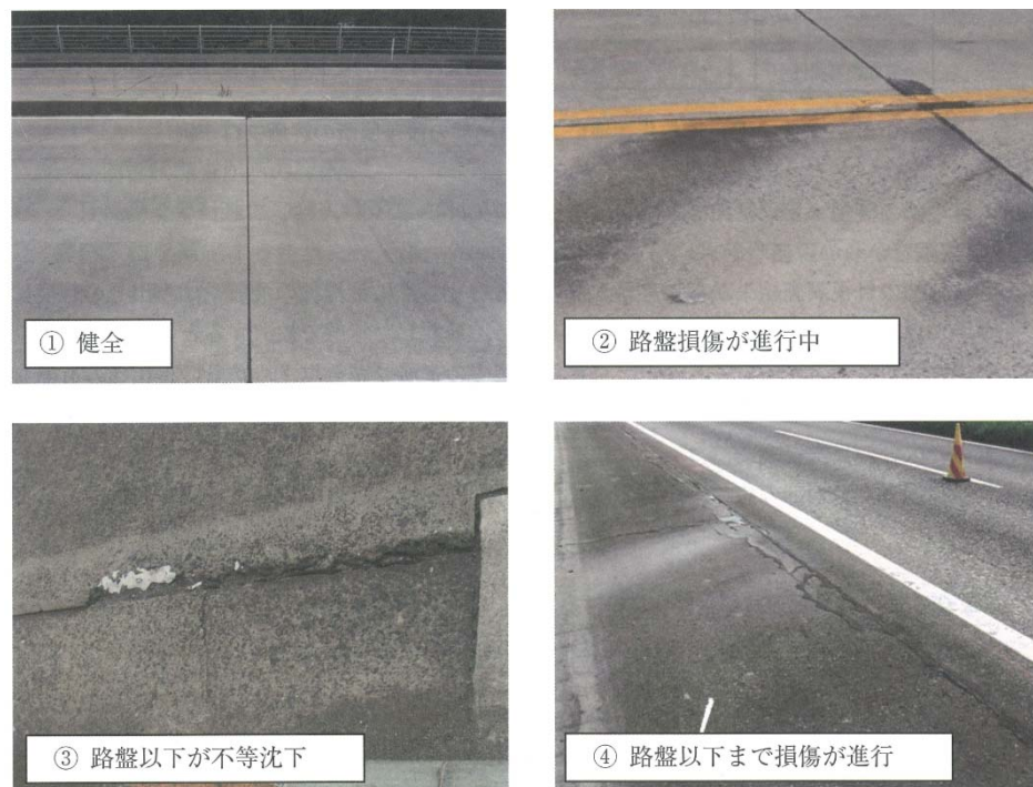
図 2-14 目地部の状態の事例
