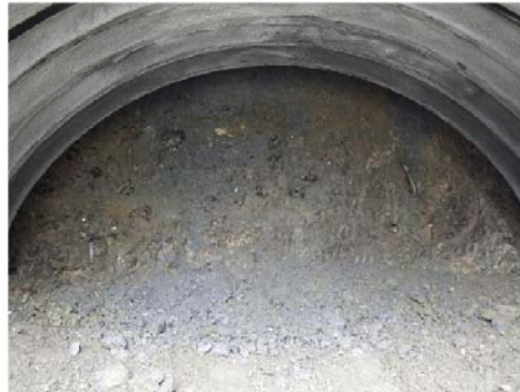
写真-2 長尺鏡ボルト打設状況
