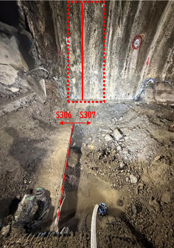
写真④：支保工復旧開始位置
