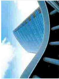
● 経典開業センタービル（ウィン・ラボラトリー）
