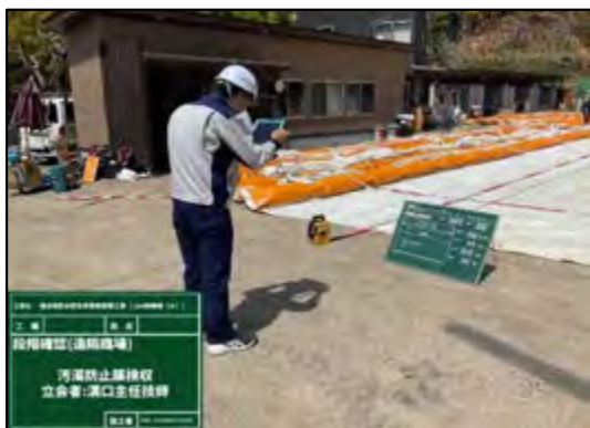
【立会状況（現場側）】
