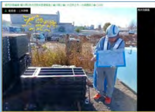
【立会状況（現場側）】
