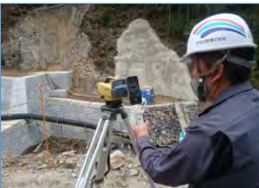
【立会状況（現場側）】
