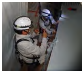
【測定箇所に照明を設置】
