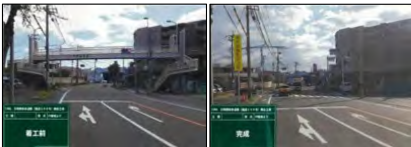
【着工前・完成】
