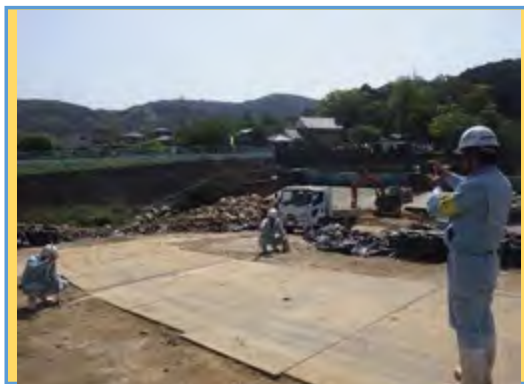
【立会状況 (現場側)】
