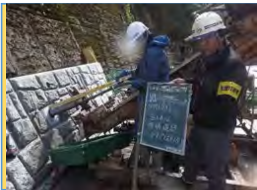
【立会状況(施工状況)】
