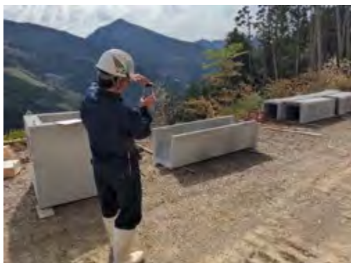
【立会状況（現場側）】
