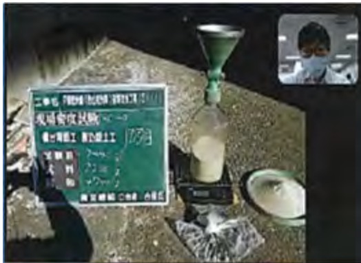
【立会状況（現場側）現場密度試験】
