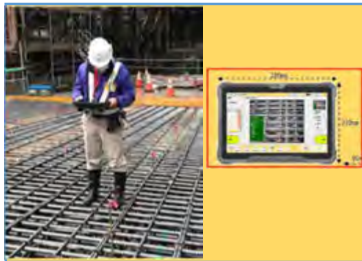
【立会状況（現場側イメージ）】
