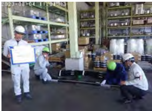
【使用材料確認（遠隔臨場）】
