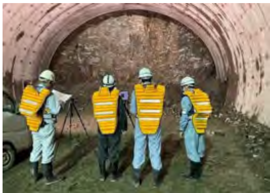
【立会状況（現場側）】
