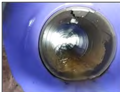
【オンライン検査（管の通り確認）】
