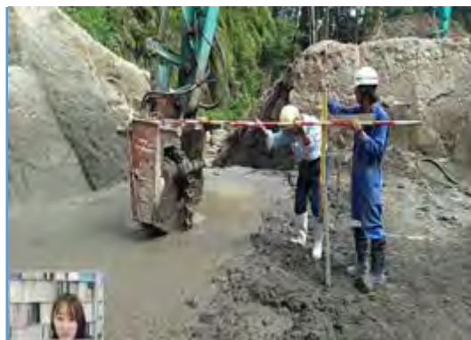
【地盤改良立会状況（現場側）】
