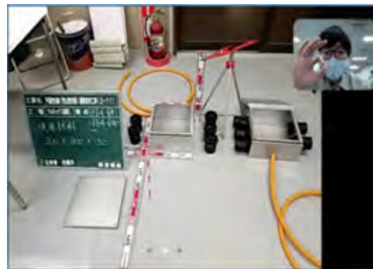
【使用材料検収の様子】
