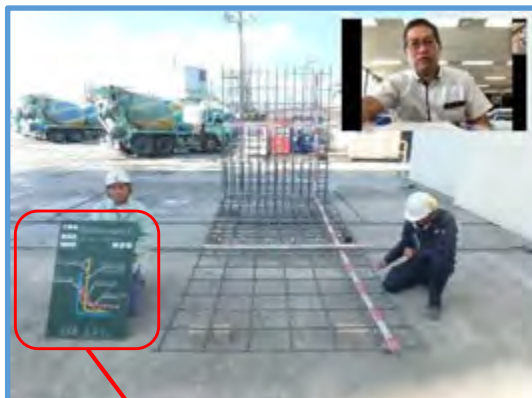
【配筋 立会状況（工場側）】
