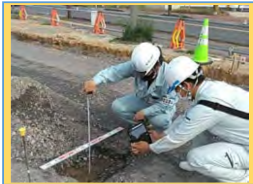
【立会状況（現場側）】
