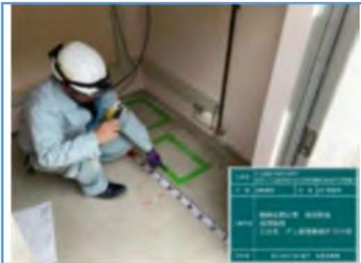
【立会状況（現場側）】
