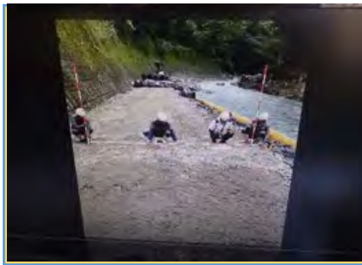
【立会状況(出来形検査)】
