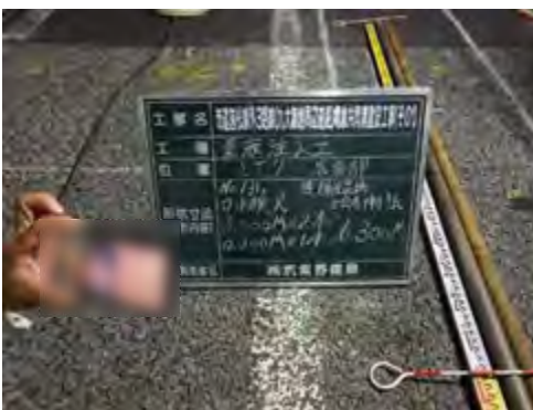
【立会状況（薬液注入口ット検尺）】
