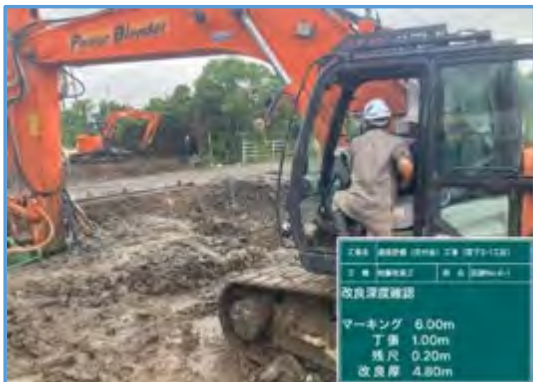
【立会状況（現場側）】
