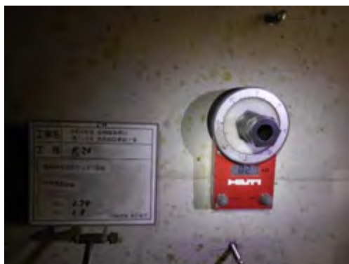
【立会状況（現場側）】
