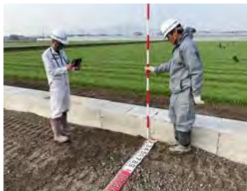
【立会状況（現場側）】
