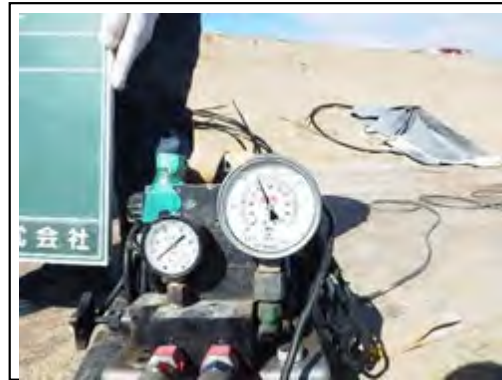
【緊張力を確認（現場側）】
