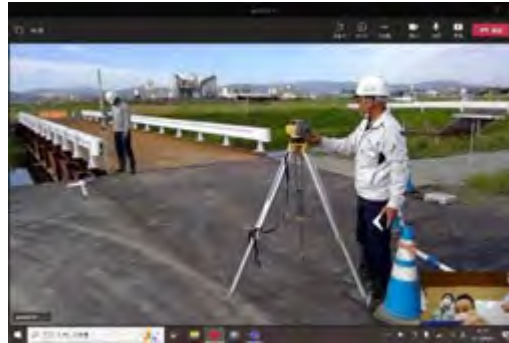
【立会状況(現場側)デジタルレベル】
