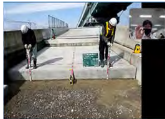
【踏掛版工の出来形検測の様子】
