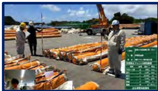
【立会状況（現場側）】
