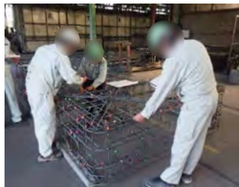
【現地状況（特殊部配筋）】
