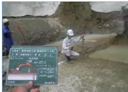
【出来形管理（杭ナビ測量）】
