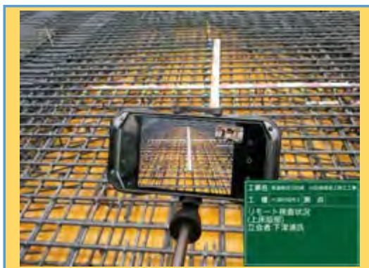
【立会状況（現場側）】
