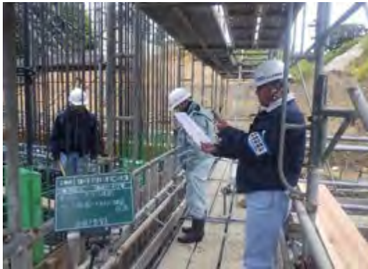
【立会状況（現場側）】
