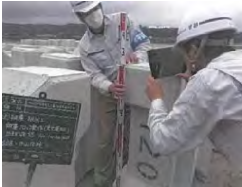
【立会状況（現場側）】
