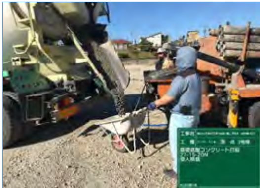
【立会状況（現場側）】
