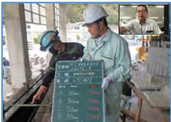
【枠内かぶり 立会状況（工場側）】
