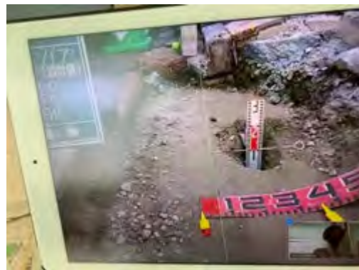
【スクリーンショットで現場状況を記録】
