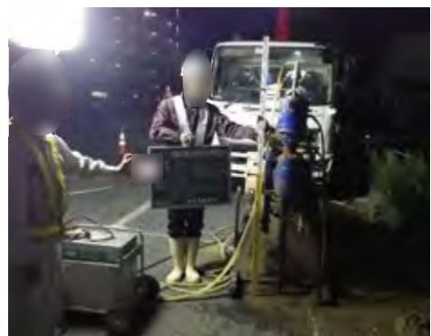
【現地状況（薬液注入口ット検尺）】
