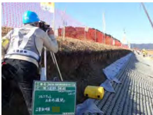
【立会状況（現場側）】
