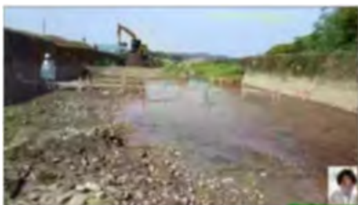
【立会状況（現場側）】
