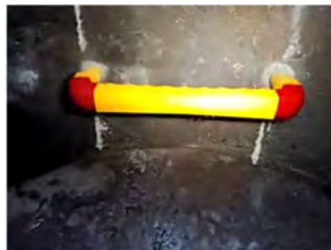
【オンライン検査（足掛金物取付確認）】
