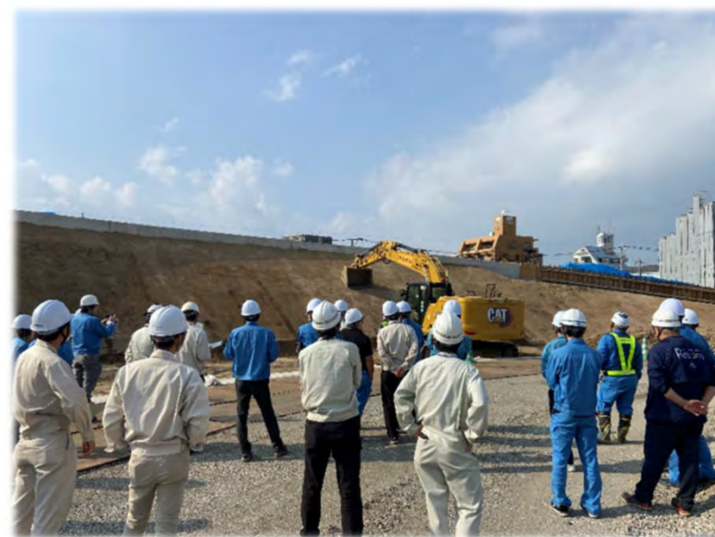
ICT施工(法面工)現場見学会
