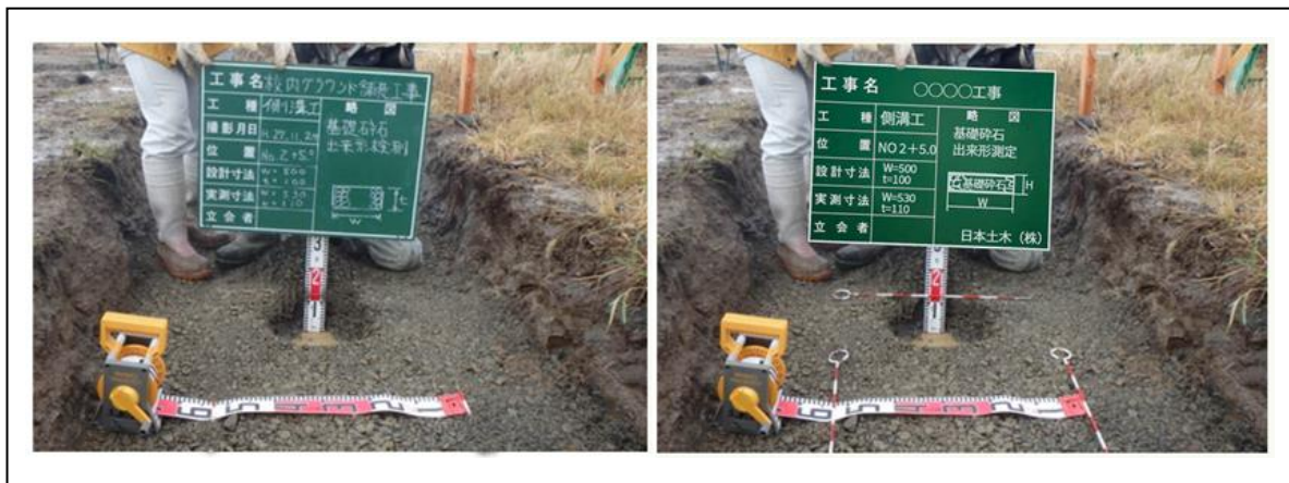
(写真Ⅱ-3) コンクリート側溝工・基礎砕石の出来形確認写真(左)と測定小物使用例(右)
