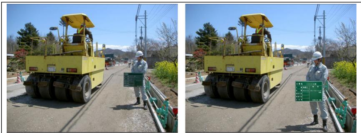
(写真Ⅱ-5) 路床に関する品質管理試験写真 悪い例(左)と良い例(右)
