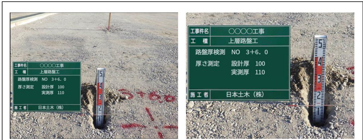
(写真Ⅱ-4) 路盤工・整正後の厚さ出来形確認写真(左)と部分図(右)
