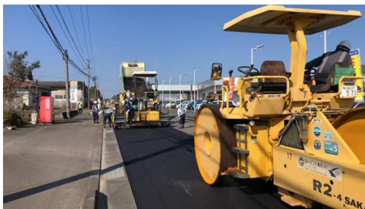
写真14 アスファルト混合物の施工状況
