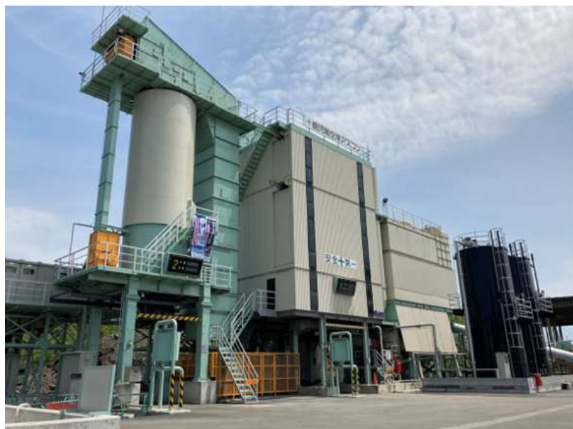
写真 1 2 アスファルト合材工場の外観
