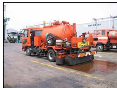
写真15 乳剤の散布状況
