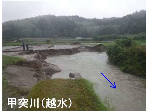
大里川(破堤)【応急復旧済】
