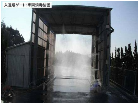
入場ゲート、車両消毒装置
