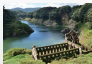
曾木発電所遺構
