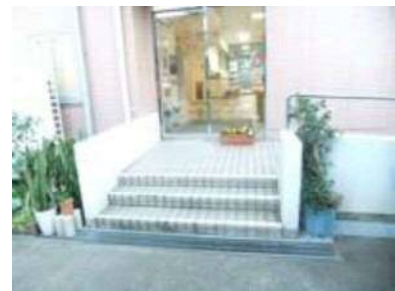
駐車場横入口幅85 cm
