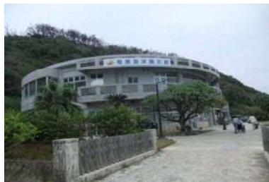
駐車場から建物までの通路
