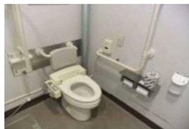
可動式手すり
