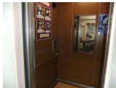
エレベーター入口幅 78 cm
