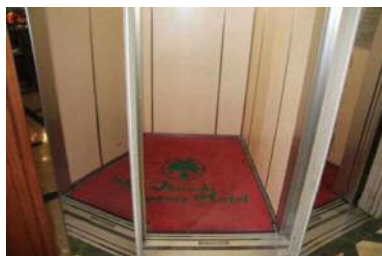
エレベーター入口幅 100 cm
