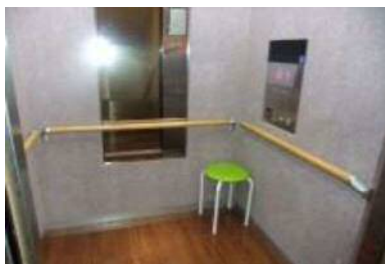
エレベーター入口幅 80 cm
