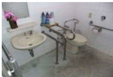
固定式手すり
