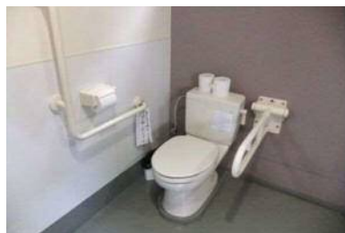
可動式手すり
