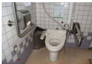
可動式手すり
