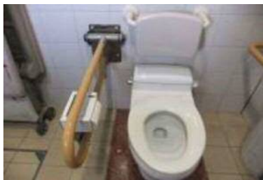
可動式手すり
