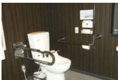
可動式手すり
