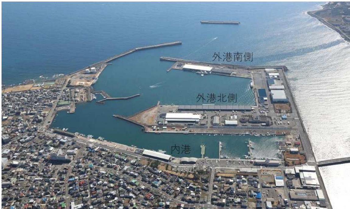
全景 平成29年 2月撮影
