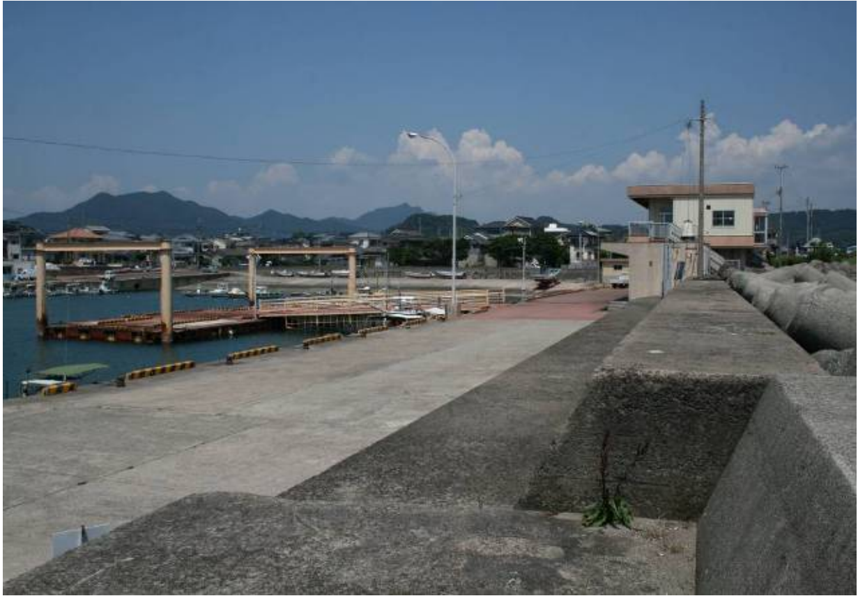
護岸改良(防風柵設置要望箇所)
