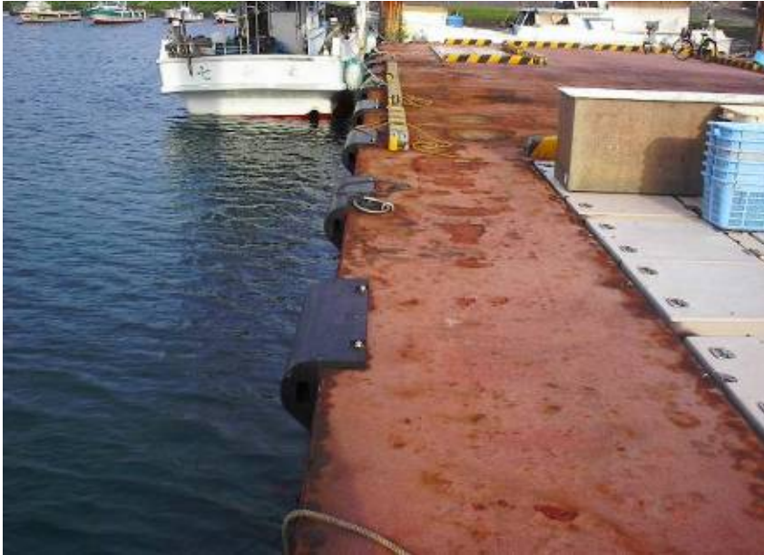
浮棧橋本体の防舷材取付状況
