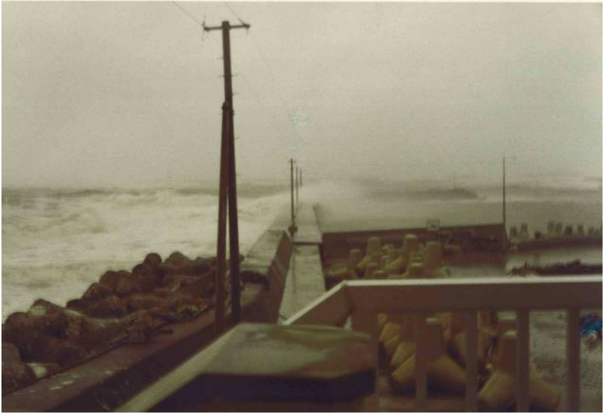
護岸改良・胸壁改良(防風柵設置要望箇所)
