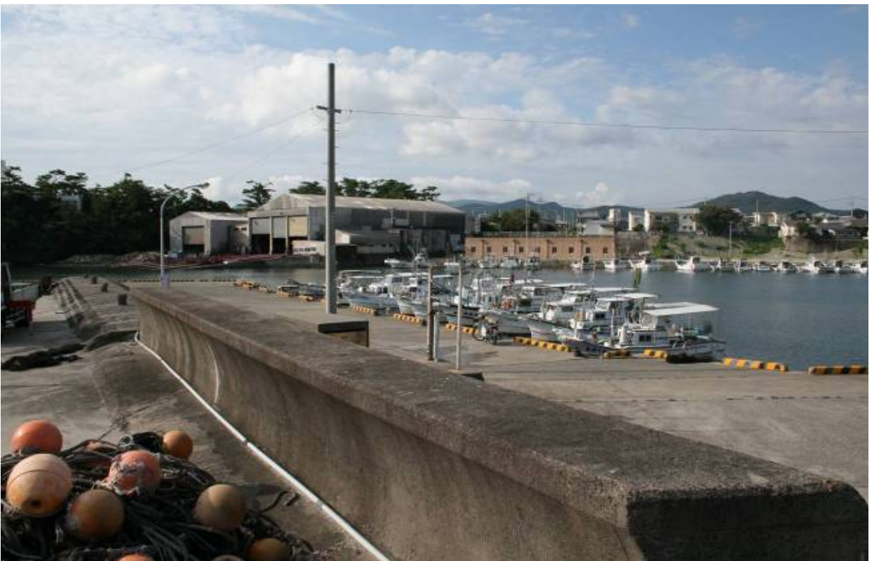
胸壁改良(防風柵設置要望箇所)
