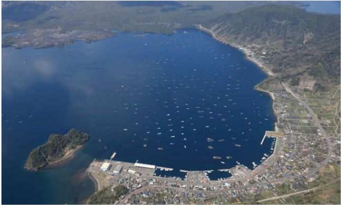
全景 平成28年 4月撮影
