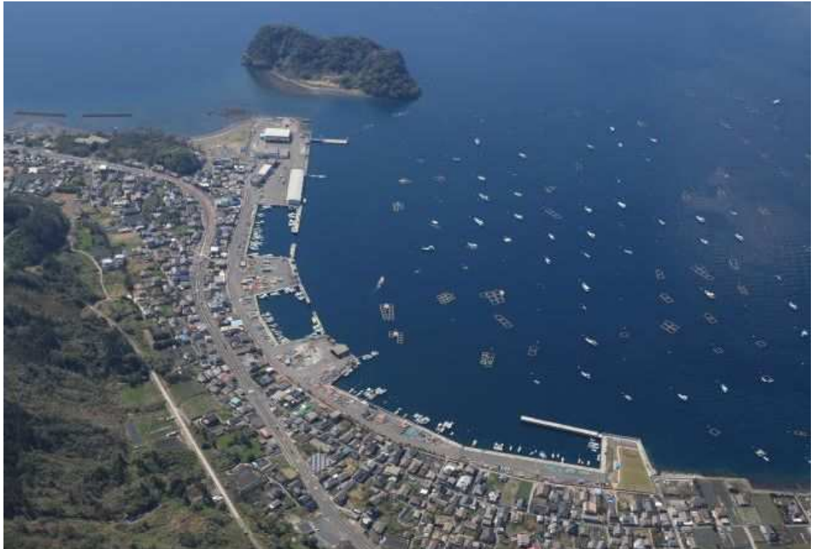
全景 平成28年 4月撮影
