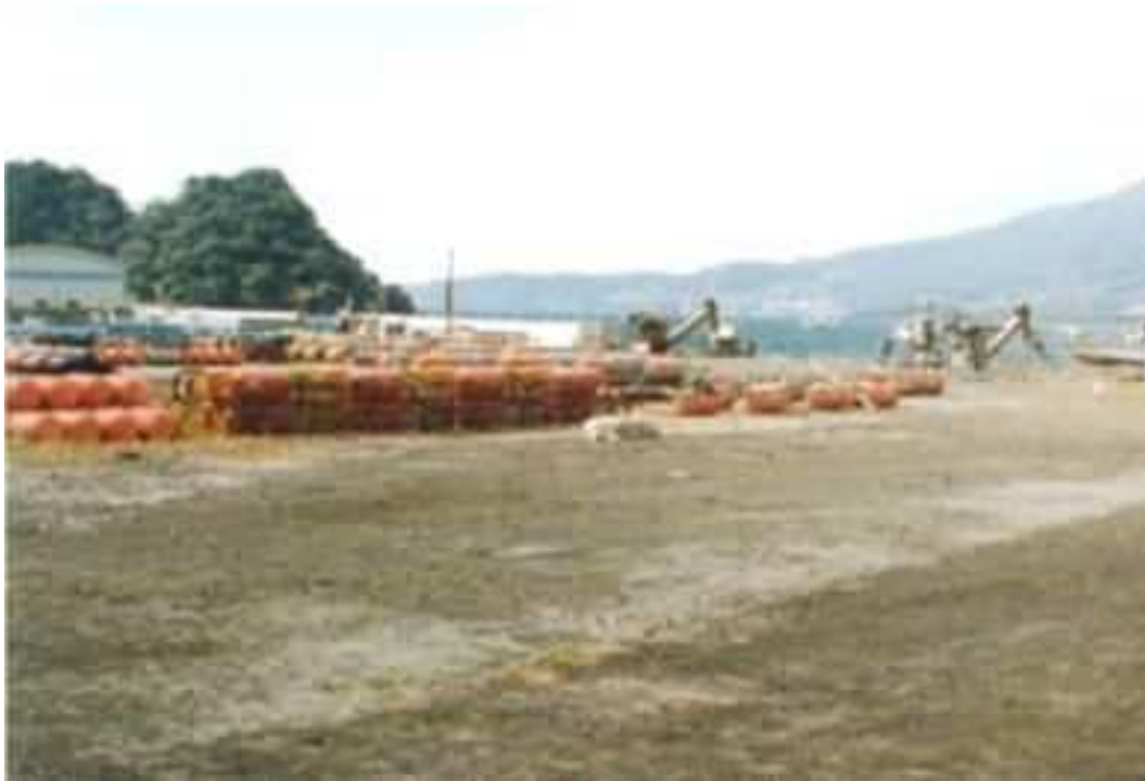
養殖作業等用地が不足しているうえ、用地の一部が未舗装のため、養殖生簀の補修や網干し作業に支障が生じている。平成16年3月撮影
