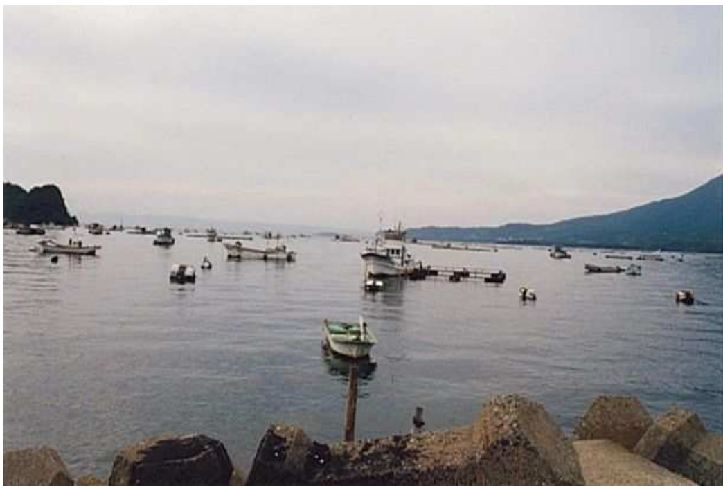
休けい岸壁が不足しており、漁港近くに係留している状況。 平成12年2月撮影
