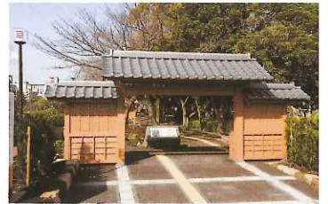
上流側は近代的な石積風の門柱をイメージ。下流側は武家門風のゲートが情緒あふれる。
