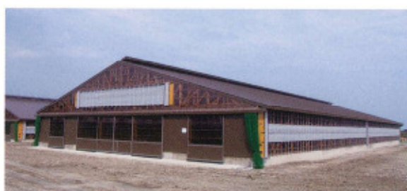
オホーツクはまなす牧場育成牛舎(北海道) 詳細参照P27 延べ面積1,774.46m 2 だが、畜舎には緩和措置があるため、防火壁(法26条3項)と小屋裏隔壁(令114条3項3号)を設けていない。
