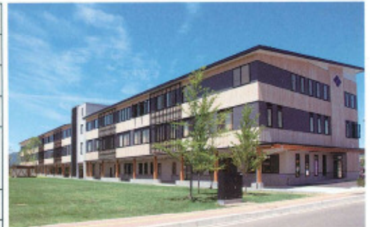
紫波町役場 (岩手県：軒高14.53m 最高高さ14.98m) 1時間準耐火建築物とした建築例
