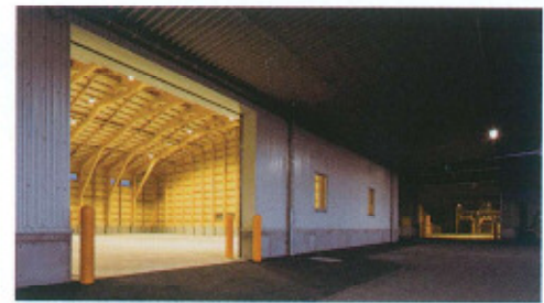
日新倉庫棟(鳥取県) 倉庫の用途に供する床面積が、1,500m 2 以上であることから、準耐火建築物とした建築例。内部をフォークリフトが走行できるよう31mのロングスパンの無柱空間とした。
