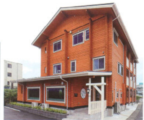
入間ログハウス3階建て複合施設（埼玉県） 1時間準耐火建築物のログハウス
