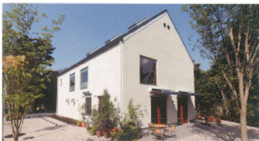
野菜倶楽部 oto no ha Café (オトノハカフェ) (東京都) 大臣認定を受けたメンブレン型耐火構造による建築例
