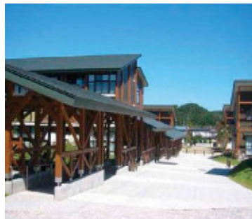
外壁の耐久性を高めるため、大きな庇、雁木を設けた事例
