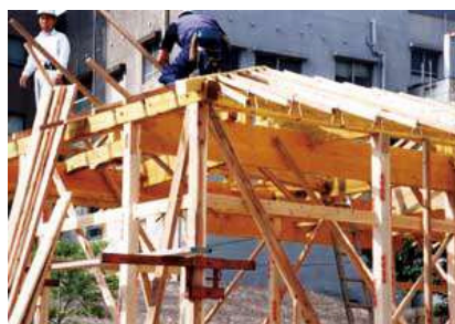
2階の構造材にも防蟻処理
