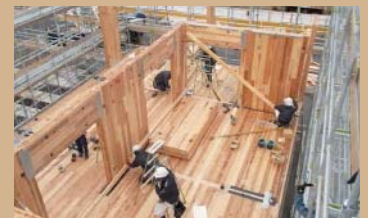
●CLT面板工法的施工狀況
