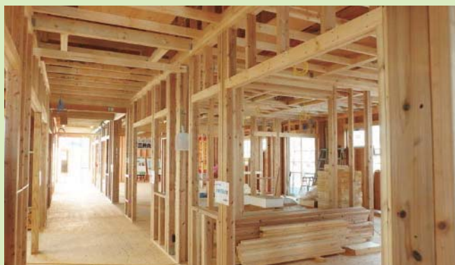
● 托兒所（施工狀況） ※使用規格材
