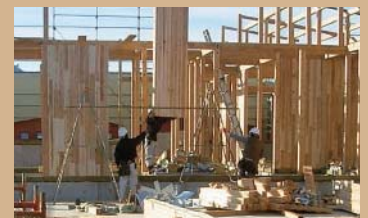
●木造軸組構法+CLT施工狀況
