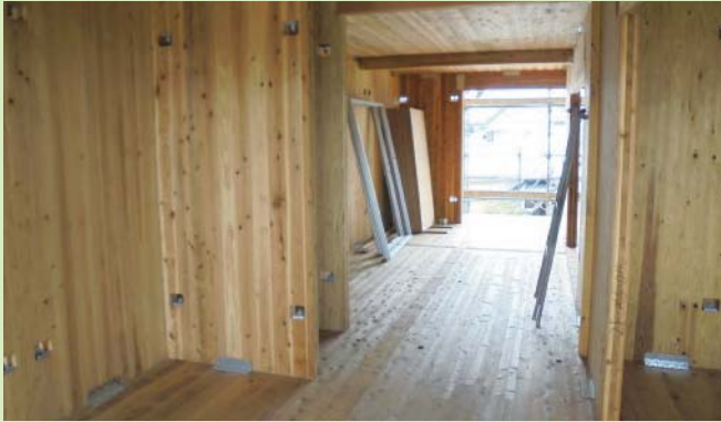
●集合住宅（施工狀況）※CLT面板工法
