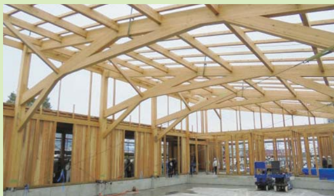
● 學校體育館（施工狀況） ※使用CLT和集成材
