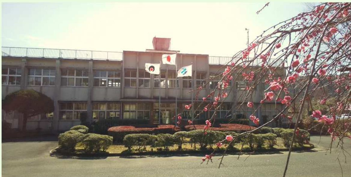
センター本館と紅梅 令和3年2月
