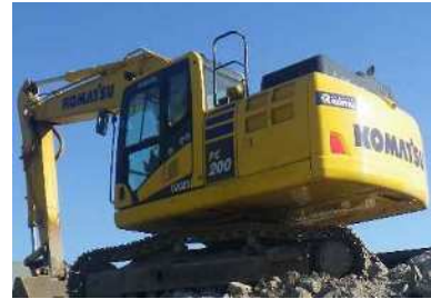
バックホウによる ガラパ Gos 投入状況
