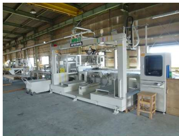
木材加工流通施設の整備 〈プレカット加工施設〉 (力強い木材産業生産性強化対策事業)
