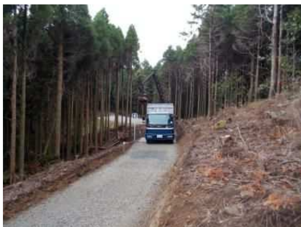
林業専用道の整備 (次世代ふるさとの森再生事業)
