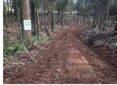
作業路網の整備
