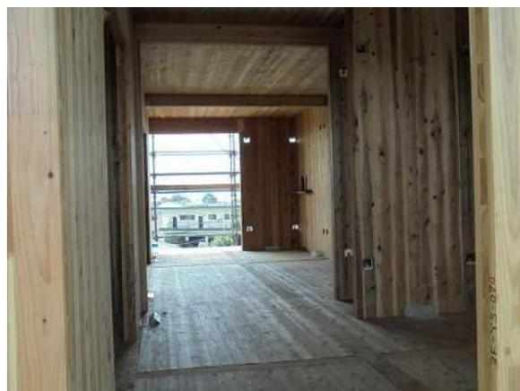
CLTパネル工法による賃貸集合住宅
