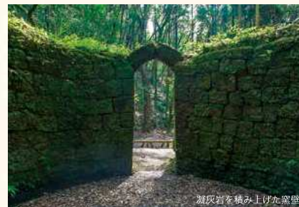
※災害復旧前の写真
