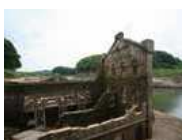
曾木発電所遺構
