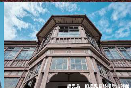
鹿児島 旧鹿児島紡績所技師館
