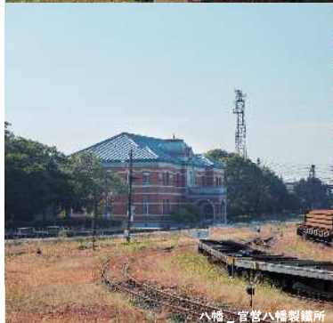
八幡 官営八幡製鐵所
