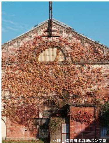
八幡 遠賀川水源ポンプ室
