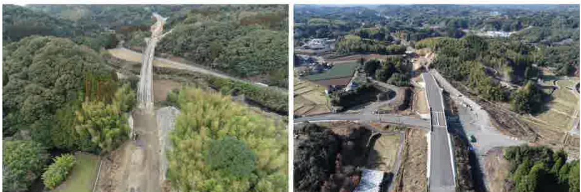
北薩横断道路（広瀬道路 左：工事中、右：完成）
