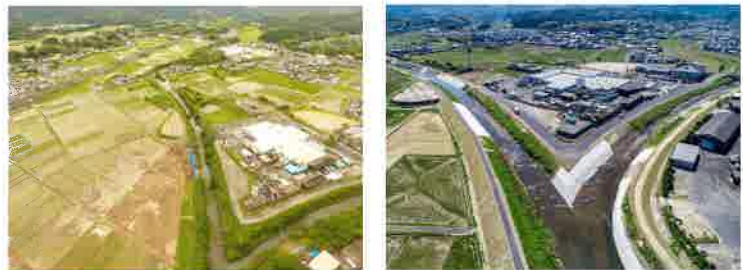
百次川・勝目川（左：着工前、右：完成）
