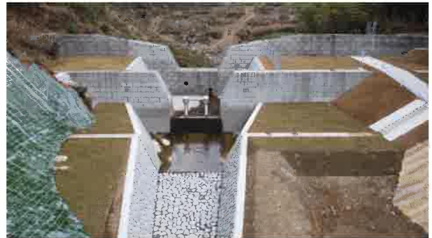
砂防えん堤（さつま町 大畝川）
