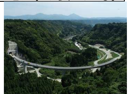
国道504号西光寺拡幅（施工中）
