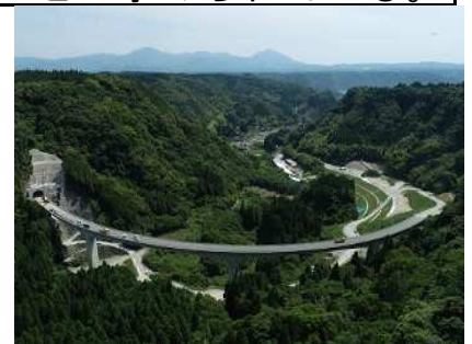
国道504号西光寺拡幅（施工中）
