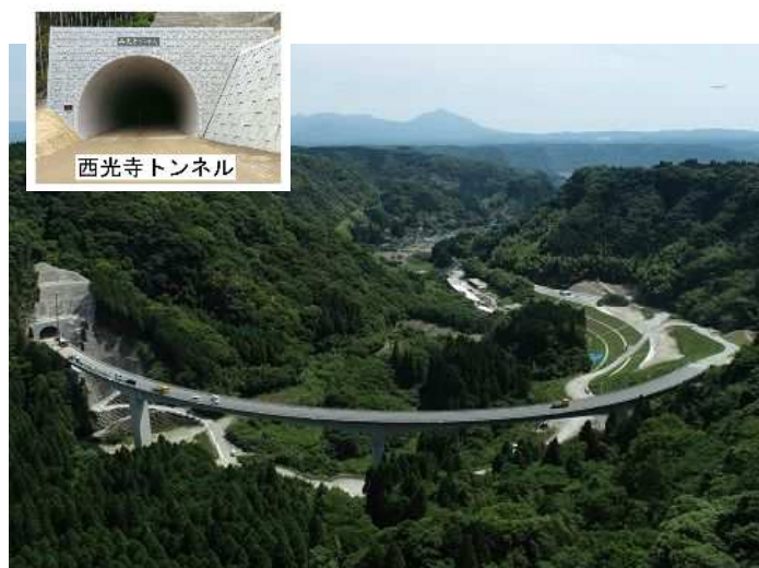
鹿児島空港と霧島市街地及び大隅地域を結ぶ国道504号西光寺拡幅（施工中）
