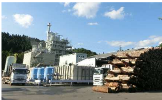
木質バイオマス発電施設
