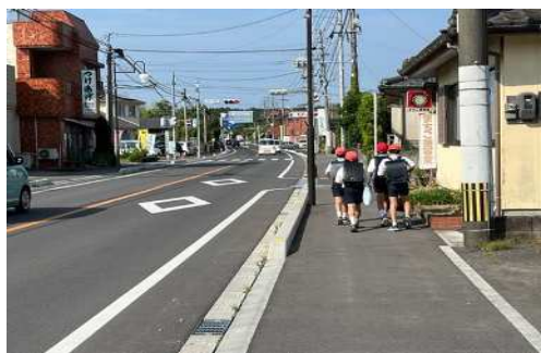
歩道の整備(万世工区)
