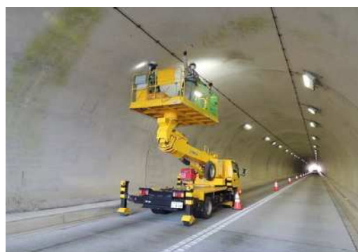
トンネルの点検状況 （丸木崎トンネル）
