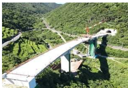
災害に強い道づくり (国道226号 笠沙道路)
