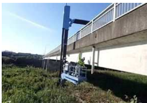
橋梁の点検状況 （万之瀬橋）
