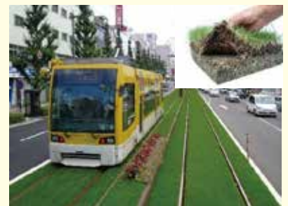
図2 緑化基盤により緑化した軌道敷
