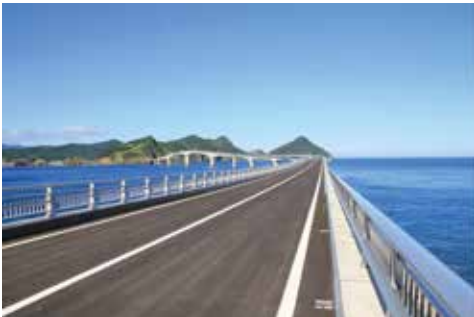
甌大橋（薩摩川内市）
