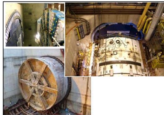
写真 VI-2 シールドマシン立坑発進
