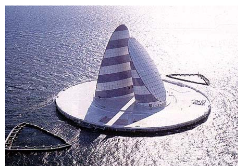
写真 IV-2 中央換気塔 (東京湾横断道路「風の塔」)
