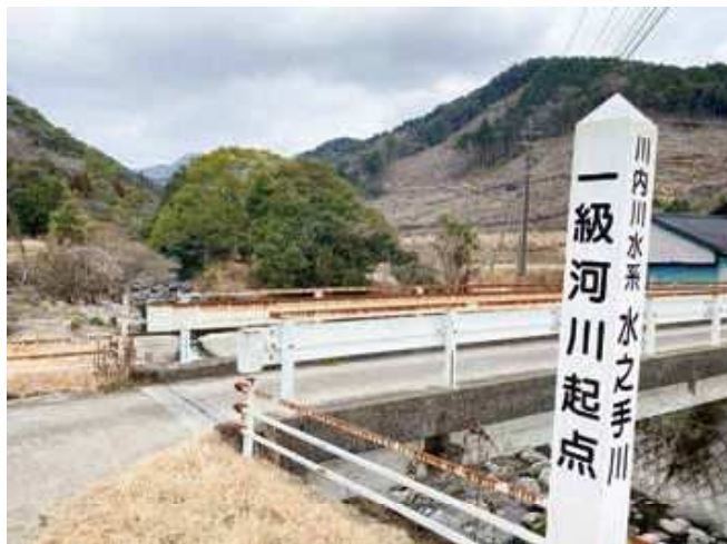
▶川内川支流 水之手川起点
