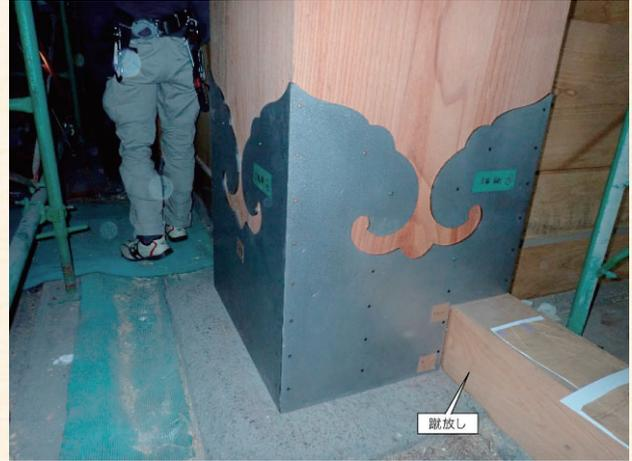
3月5日に、京都の工場で作製され、漆の焼付け塗装された沓巻金物が、鏡柱(かがみばしら)に取り付けました。鏡柱にピッタリと合っています。
