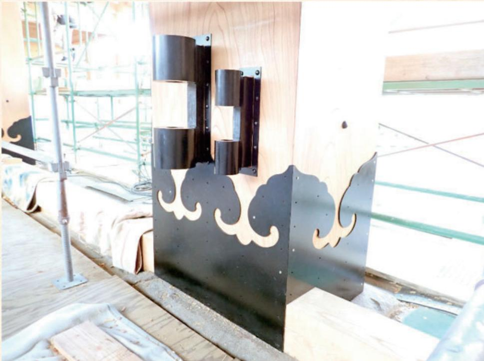
3月17日には、柱の四角に取り付ける筋金(すじがね)も鶴丸城御楼門の現場に到着し、金物の取付け工事が、本格的に始まりました。
