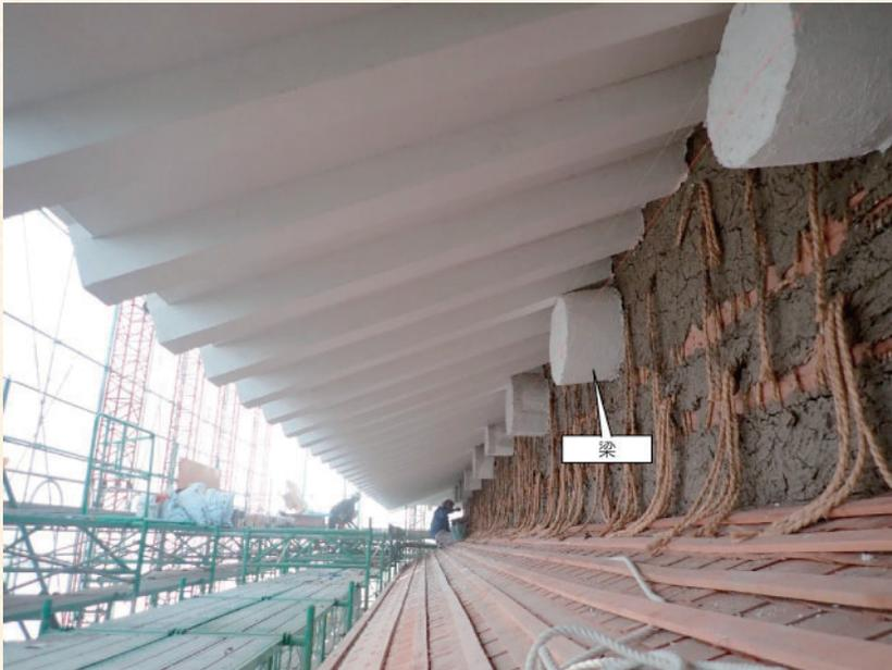
下層屋根の軒裏は、出桁(でげた)の角に木製の定規を張り、角の線がハッキリと出るように、砂漆喰を塗り重ねていきます。
