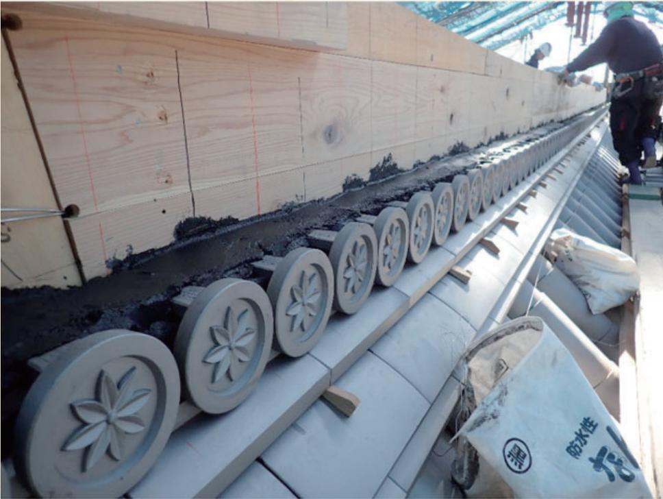
大棟の鬼際と中央部に、棟の断面を表す遣り方を掛けて、その勾配に合わせて、棟の熨斗瓦(のしがわら)を積んでいきます。
