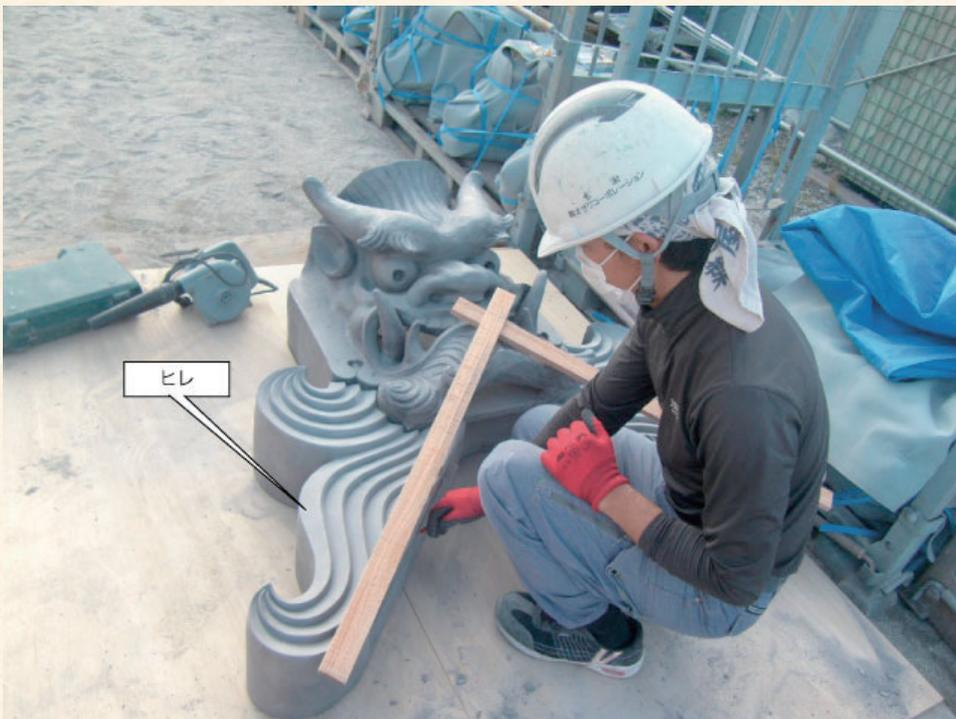
鬼瓦の鰭の部分が据わる箇所を、グラインダーで削って合わせます。
