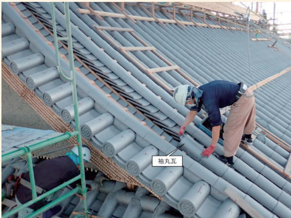
平瓦の曲線に合わせて、切り合わせて納めます。
