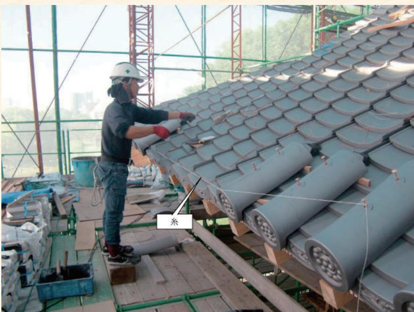
軒巴瓦も、瓦の大きさ・紋様は、鶴丸城跡の発掘調査で出土した瓦(写真右下)を基に製作しています。
