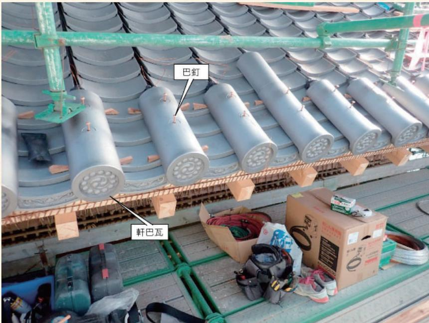
軒巴瓦の先端部が揃うよう先端部に糸を張り、通りよく並べていきます。
