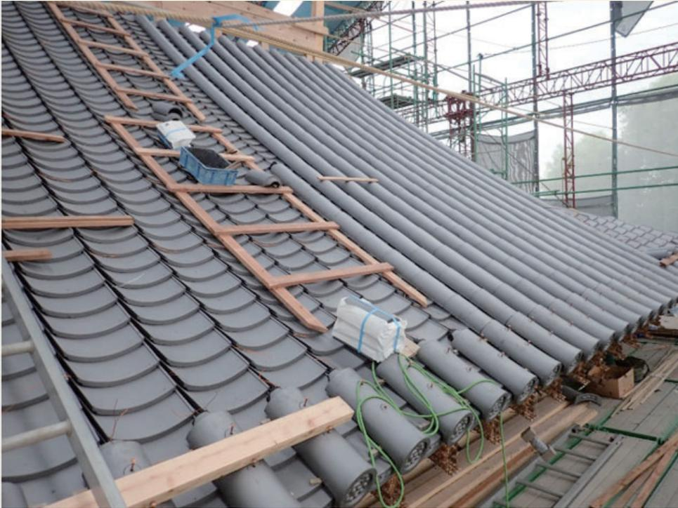
素丸瓦の下端に細いチェーンを張り、チェーンの弛みに合わせて素丸瓦を並べていきます。
